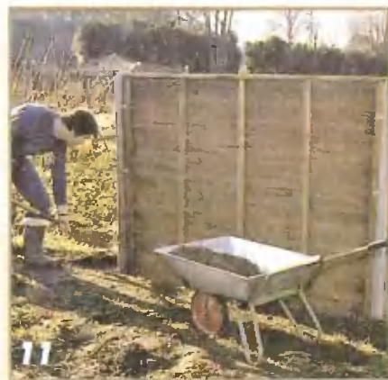
Установите следующую стойку.
