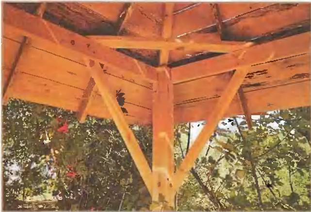
Углы беседки обязаны подкосами и горизонтальными планками.
