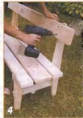
Установка доски спинки на ножках скамьи.
