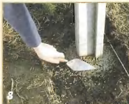
Загладьте поверхность бетона.
