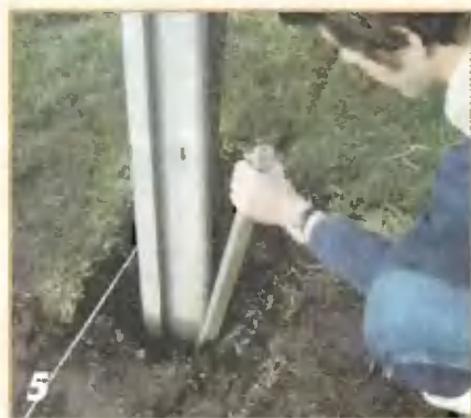
Установив стойку, закрепите ее утрамбованным крупным щебнем.
