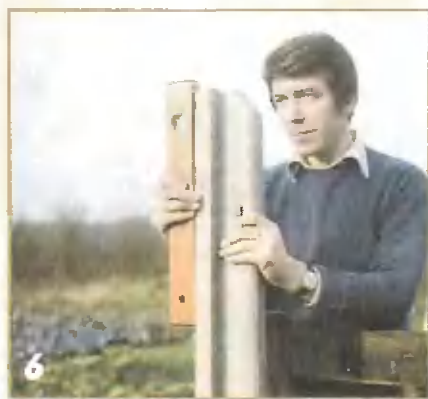
Проверьте вертикальность стойки.
