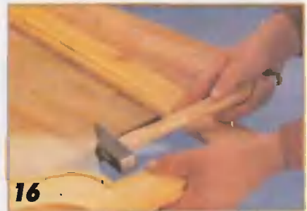
16 Стекла фиксируют на своем месте узким штапиком и стекельными штифтами (небольшими гвоздиками).
