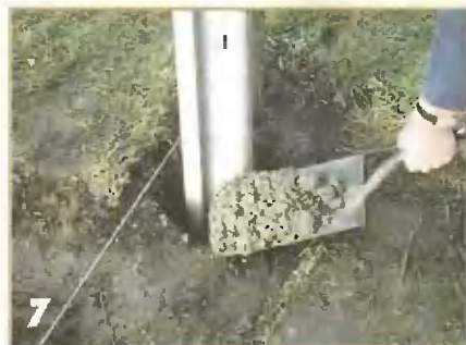
Забетонируйте основание стойки.
