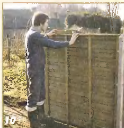
Проверяйте горизонтальность каждой устанавливаемой панели.
