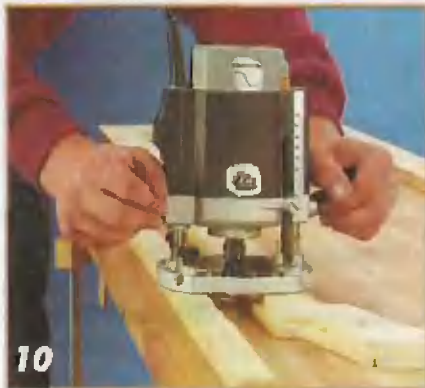
10 С внутренних и внешних кромок деталей 22–24 выбирают со стороны шкафа фальц. В детали 21 — только со стороны филенки.
