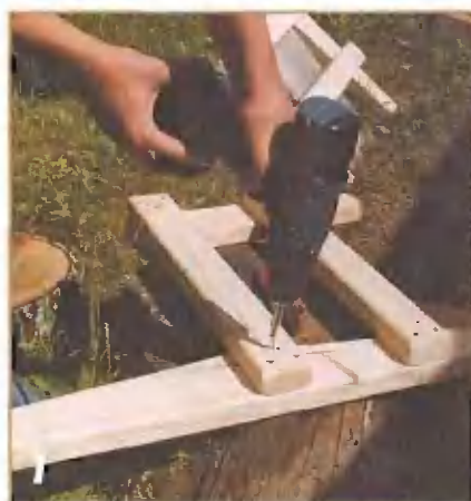
Сборка на саморезах правой ножки скамьи из подготовленных деталей (левая на фото — вдали).
