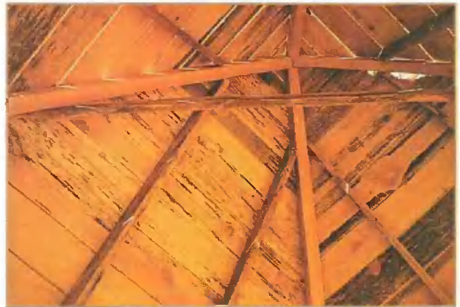
Вид снизу на стропильные балки беседки.
